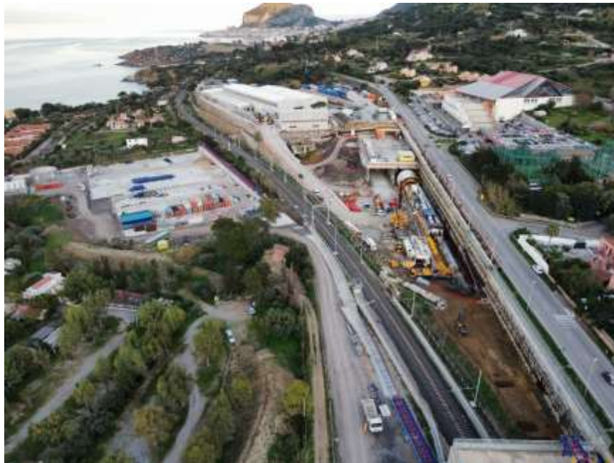
Immagine del cantiere di partenza della TBM per lo scavo della galleria Cefalù
