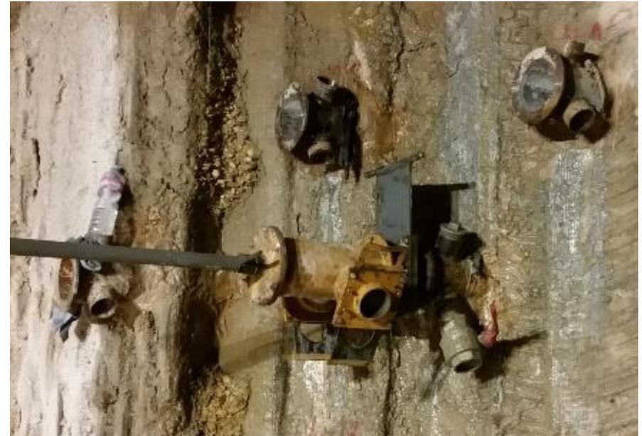
**Nelle ultime settimane è stato messo a punto un metodo di perforazione che consente di realizzare i fori più problematici al solaio 3,70.**
