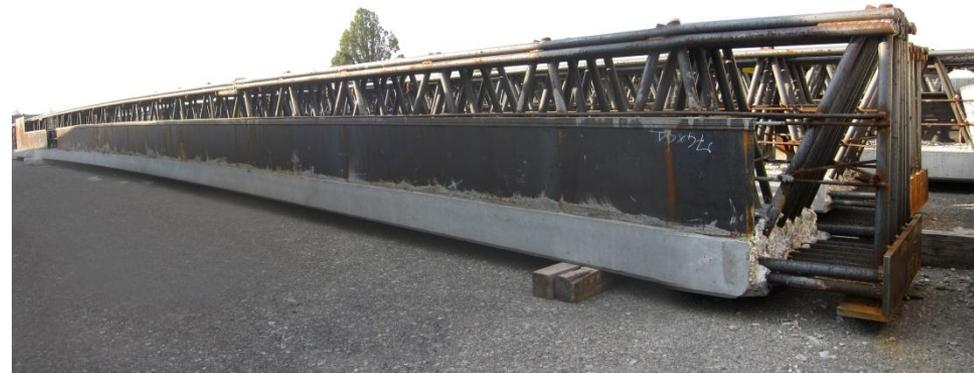
Necessità della monta costruttiva di 15 cm per una luce di 19,5 m
